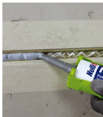
Spáru můžete poté podle potřeby utěsnit pomocí Nullifire FS703, FS704 nebo illbruck SP525.
