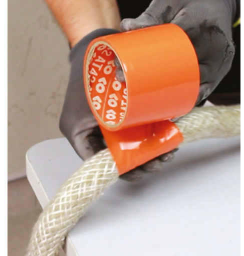
Nullifire FJ203 abkleben, um das Zuschneiden zu erleichtern
